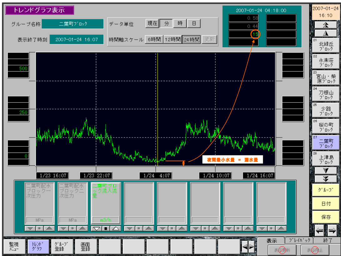
図-3.4 監視制御システムのトレンドグラフ表示
